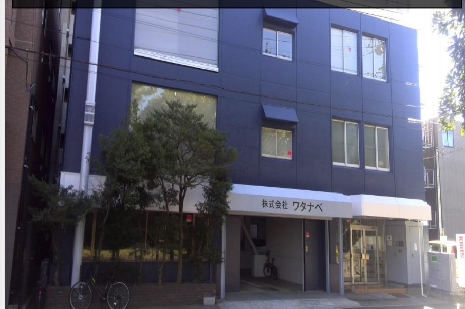
株式会社ワタナベ 新横浜本社外観
